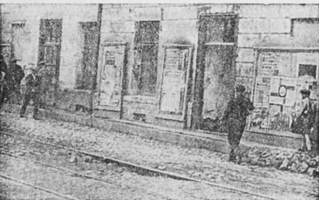
Мостовые нуждаются в усиленном ремонте
